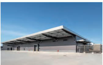
柱がない巨大な大屋根を設置。柱がないので車両を止めやすく、悪天候でも搬入搬出の荷物が濡れない。
