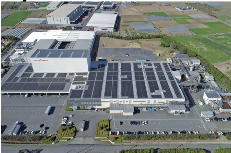
約200人の従業員が働くポッカサッポロフード&ピバレッジ群馬工場
