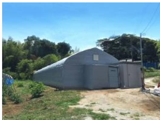
地中熱を活用したキクラゲ栽培施設
