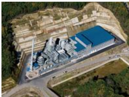
発電併用焼却施設の外観 (出所:富山環境整備HP)
