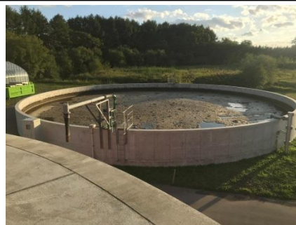
消化液貯留槽
