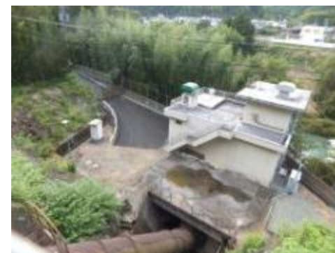
波多瀬発電所
