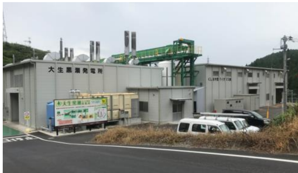
大生(おおば)黒潮発電所の外観
