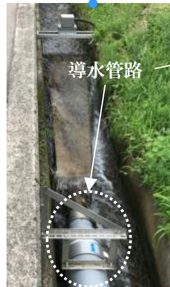
排水路取水点
